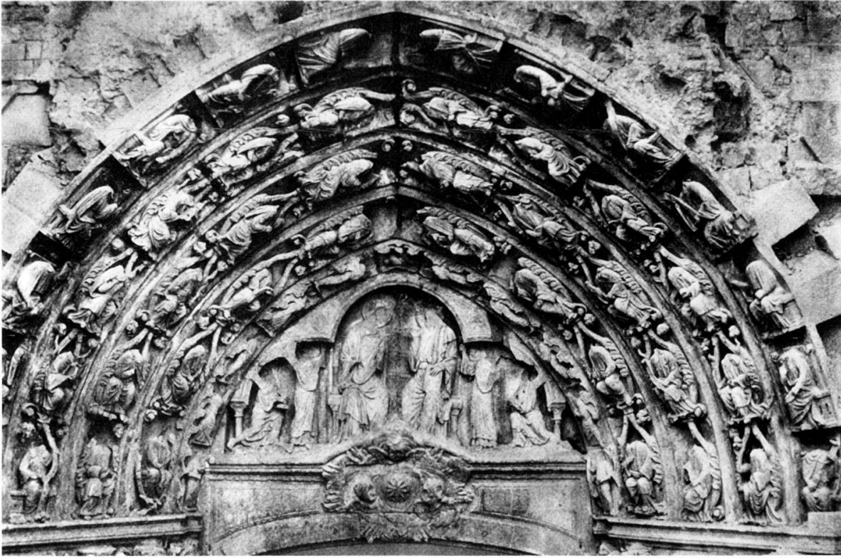
31 Laon (Aisne), Kathedrale Notre-Dame. Tympanon und gekahlte, figurenbesetzte Archivolten des mittleren Westportals, um 1195–1205. Zustand vor der Restaurierung.
