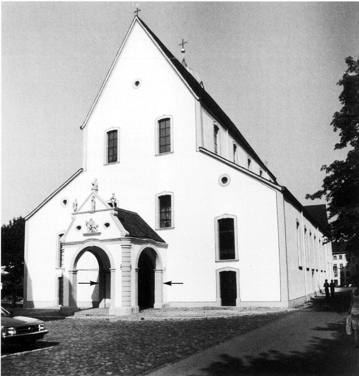
2 Rheinfelden, ehemalige Stiftskirche St. Martin, Westfassade mit Vorhalle.
