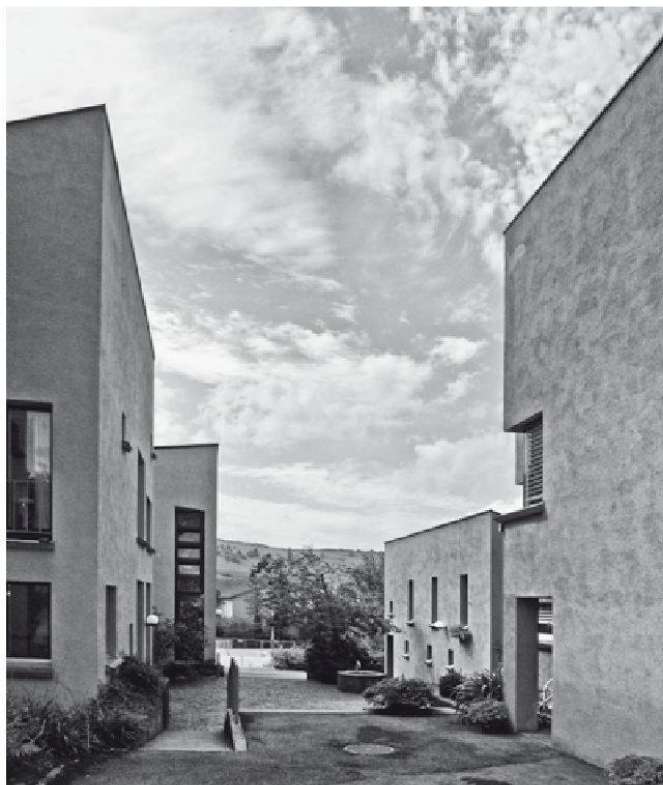
Evangelisch-reformierte Kirchgemeindehaus «Gässli» mit Pfarrhaus und Kindergarten in Magden, Architekt: Curt Peter Blumer, erbaut 1976/77, Aussenansicht (Foto: Kantonale Denkmalpflege Aargau, Aufnahme von Anke Köth).
