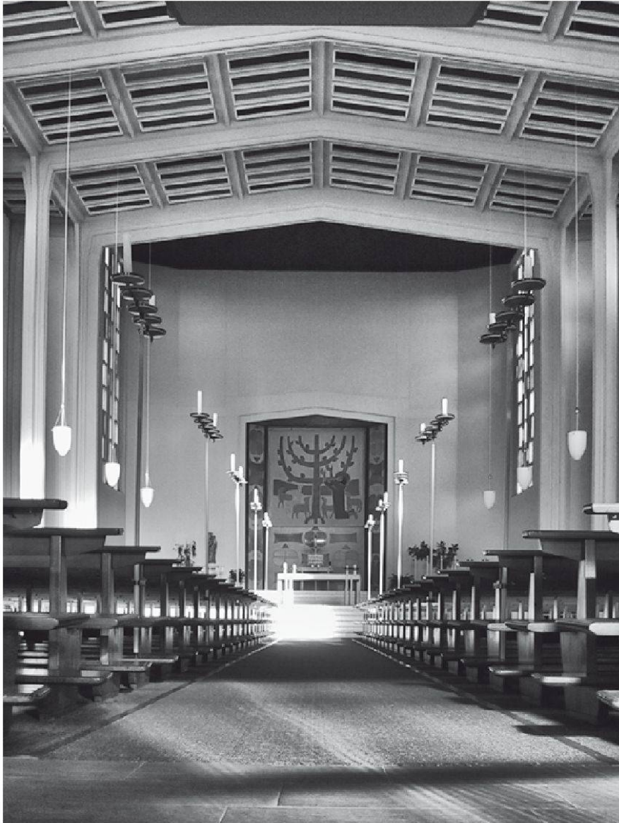
Römisch-katholische Pfarrkirche St. Anton in Wettingen, Architekt: Karl Higi, erbaut 1952–1954, Innenansicht (Foto: Römisch-katholische Kirchgemeinde St. Anton in Wettingen).
