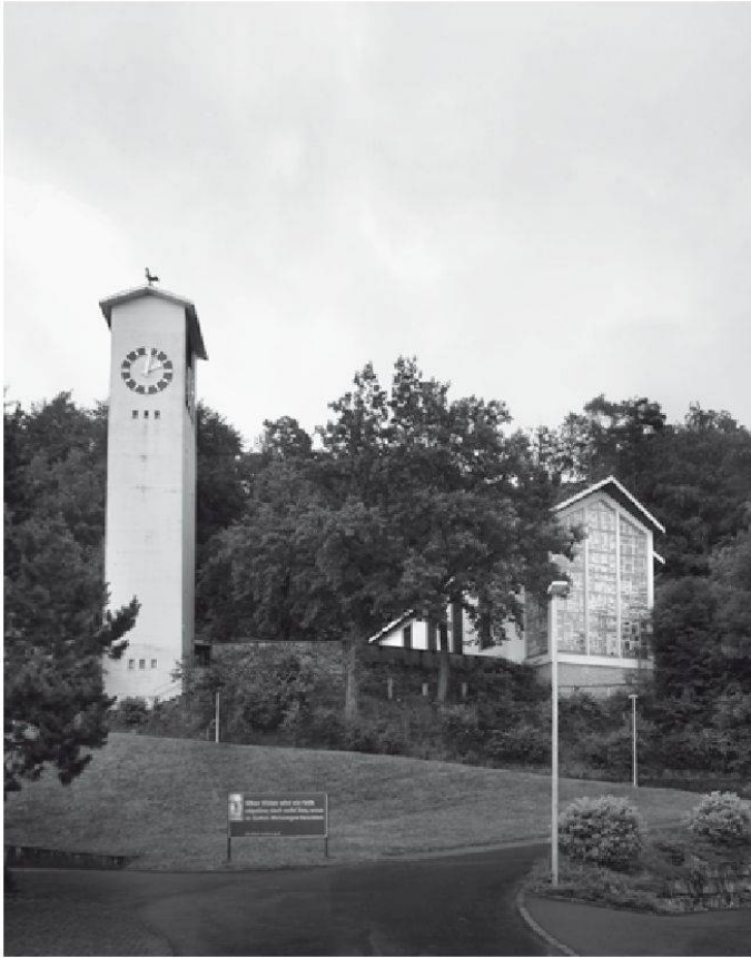
Evangelisch-reformierte Kirche und angebauter Kirchensaal in Muhlen, Architekt: Hans Hauri, erbaut 1960/61, Aussenansicht (Foto: Kantonale Denkmalpflege Aargau, Aufnahme von Anke Köth).
