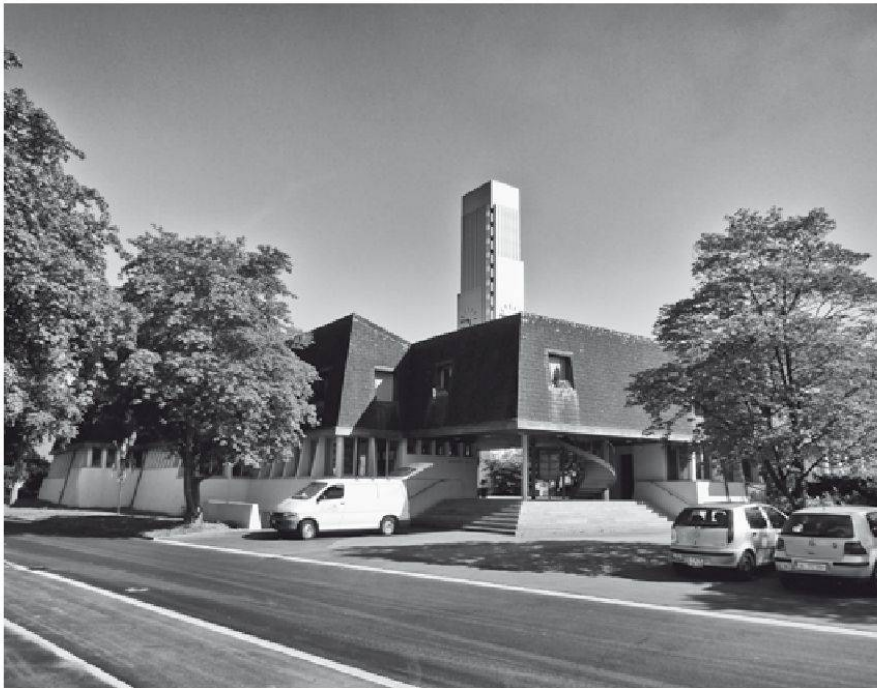
Evangelisch-reformiertes Kirchenzentrum mit Kirche und Pfarrhaus in Untersiggenthal, Architekt: Gottfried Siegenthaler, erbaut 1963–1965, Aussenansicht (Foto: Kantonale Denkmalpflege Aargau, Aufnahme von Anke Köth).
