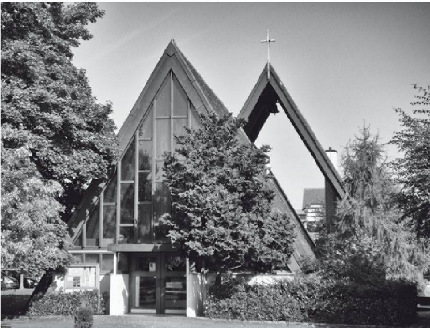
Römisch-katholische Pauluskirche Birrfeld in Lupfig, Planung Josef Wernle und Firma HORTA AG, Zürich, erbaut 1966, Aussenansicht (Foto: Kantonale Denkmalpflege Aargau, Aufnahme von Anke Köth).
