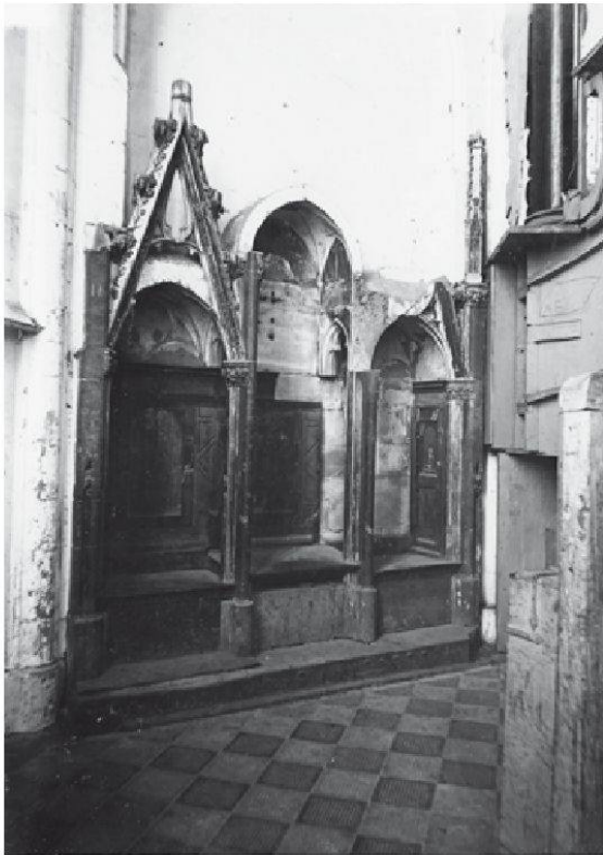
11 Zürich, Verenamünster, Fotografie der Pontifikalsitze vor Beginn der Restaurierung im Jahr 1900 (Bild: ETH Zürich, gta Archiv).
