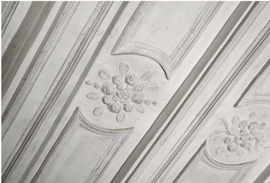
8 Schneisingen, Schössli, 2. Obergeschoss: Korridor mit stuckierter Balkendecke. Giovanni Bettini, 1696–1698 (Foto: Kantonale Denkmalpflege Aargau, Christine Seiler, 2013).
