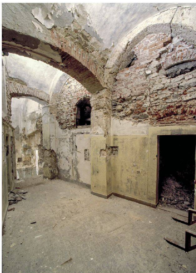
10 Tuffsteinarkaden des hochmittelalterlichen Badehauses im «Ochsen». Die Zumauerungen sowie das Tonnengewölbe datieren ins 18. und 19. Jahrhundert. Vor der Tuffsäule in der Bildmitte befindet sich (auf dem Bild kaum erkennbar) die Fassung der Paradiesquelle.
