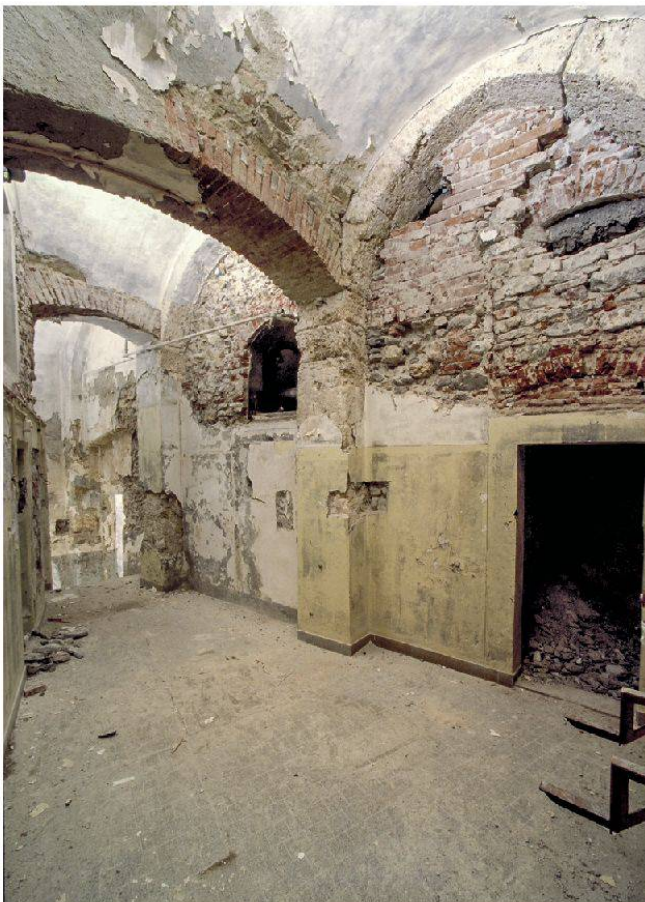
10 Tuffsteinarkaden des hochmittelalterlichen Badehauses im «Ochsen». Die Zumauerungen sowie das Tonnengewölbe datieren ins 18. und 19. Jahrhundert. Vor der Tuffsäule in der Bildmitte befindet sich (auf dem Bild kaum erkennbar) die Fassung der Paradiesquelle.
