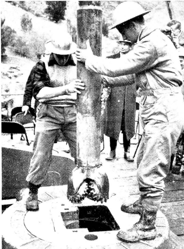
Hier wird ein Bohrmeißel durch das Loch des Bohrtisches eingeführt (Photo BP)
