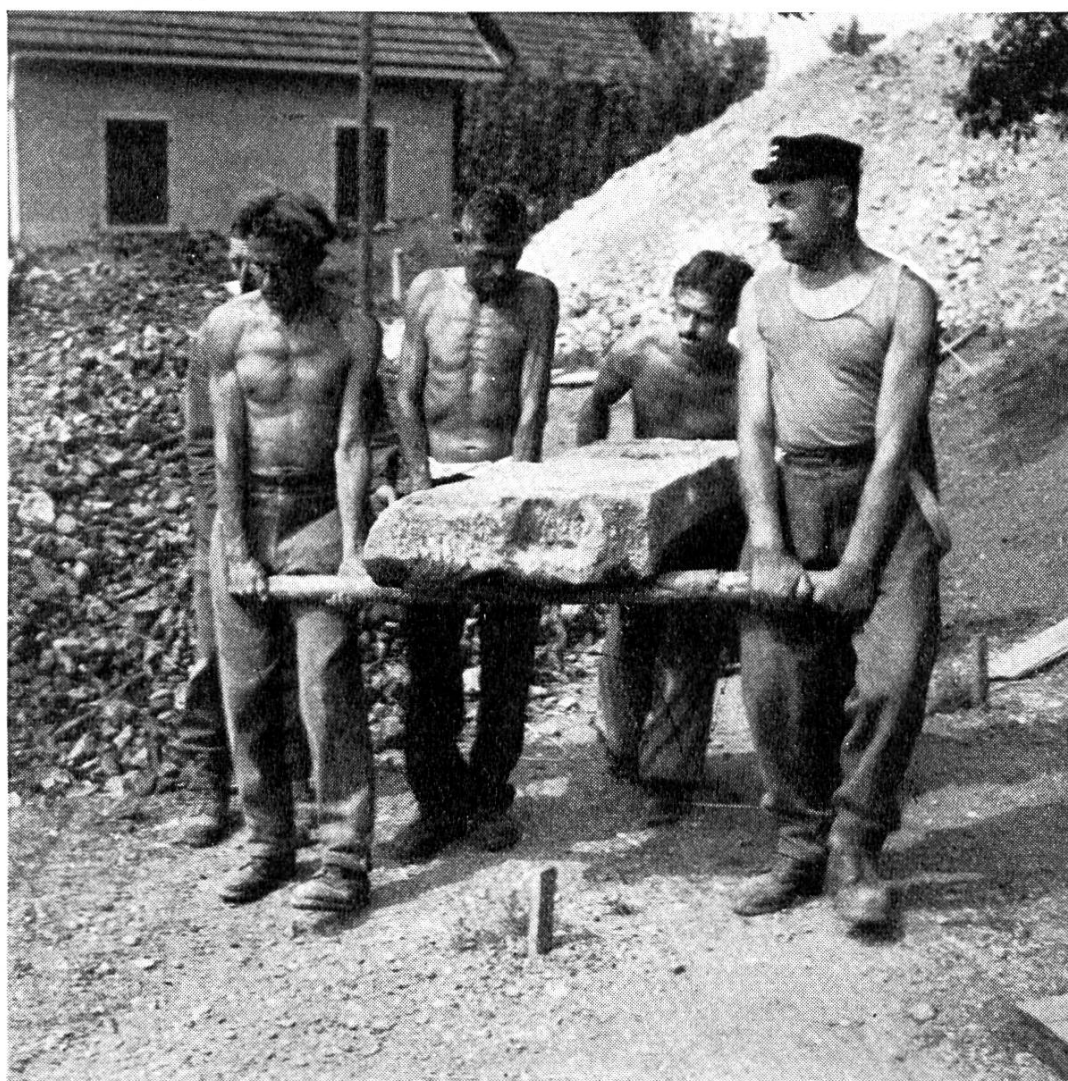
Abb. 8. Ein römischer Quader wird transportiert. (Arbeitsdienst Augst).
