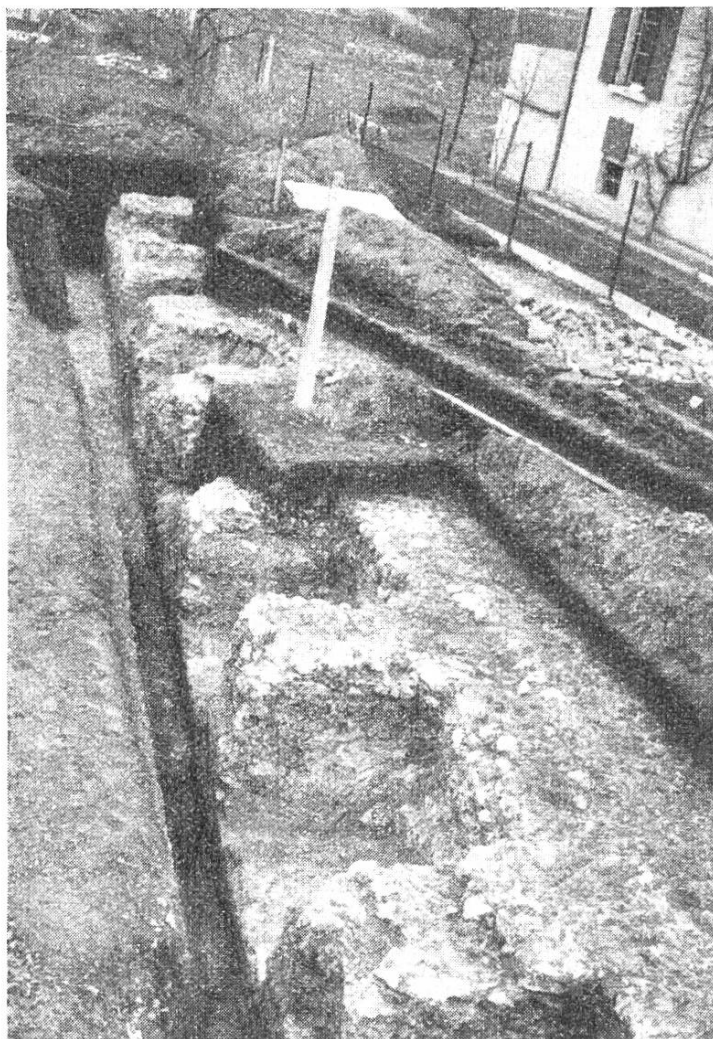
Fig. 1. Avenches. Le „podium“ du grand temple avec les empreintes du gros appareil.
