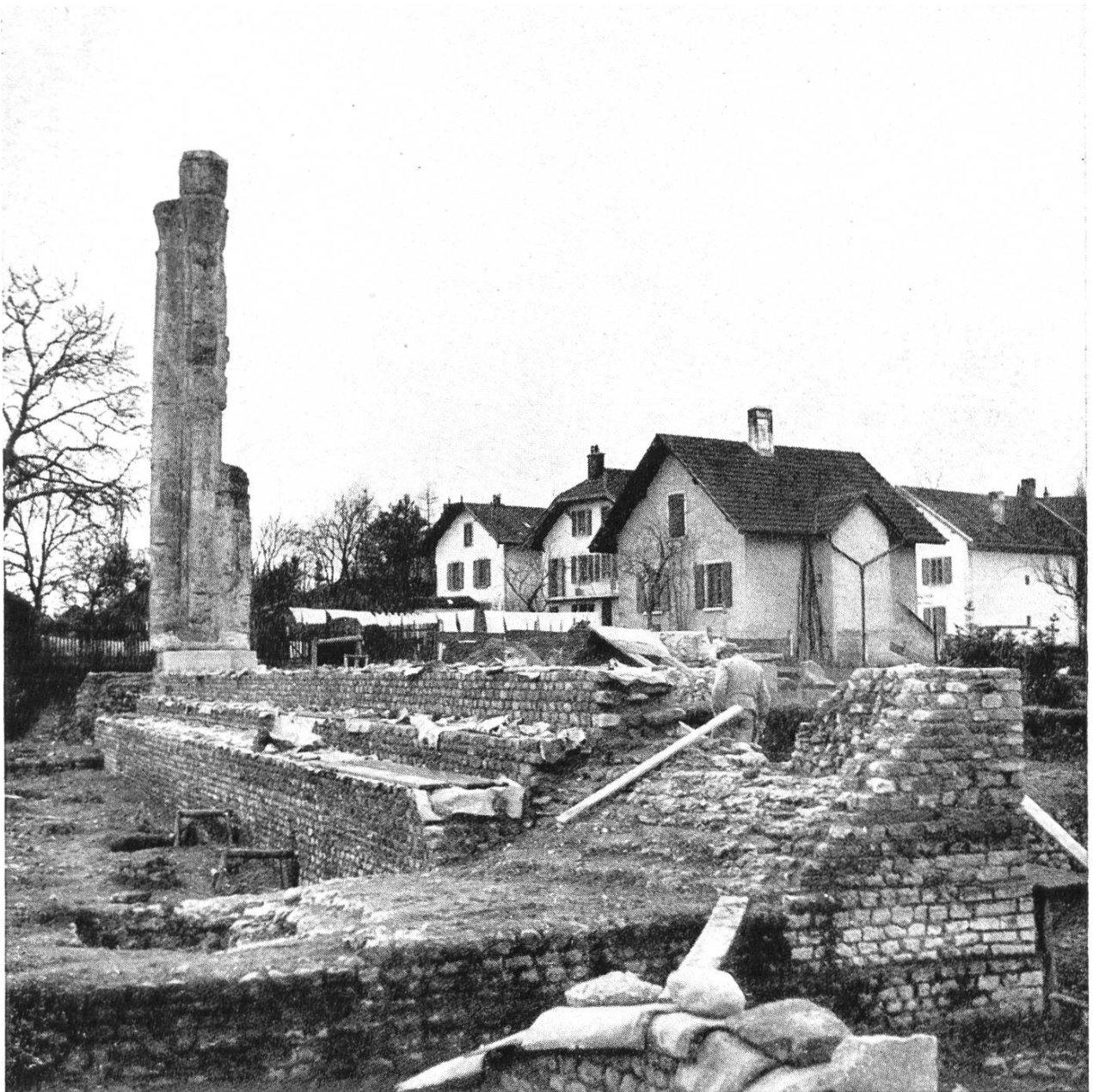
Fig. 7. Avenches. Restauration des gradins du portique près du Cigognier.
