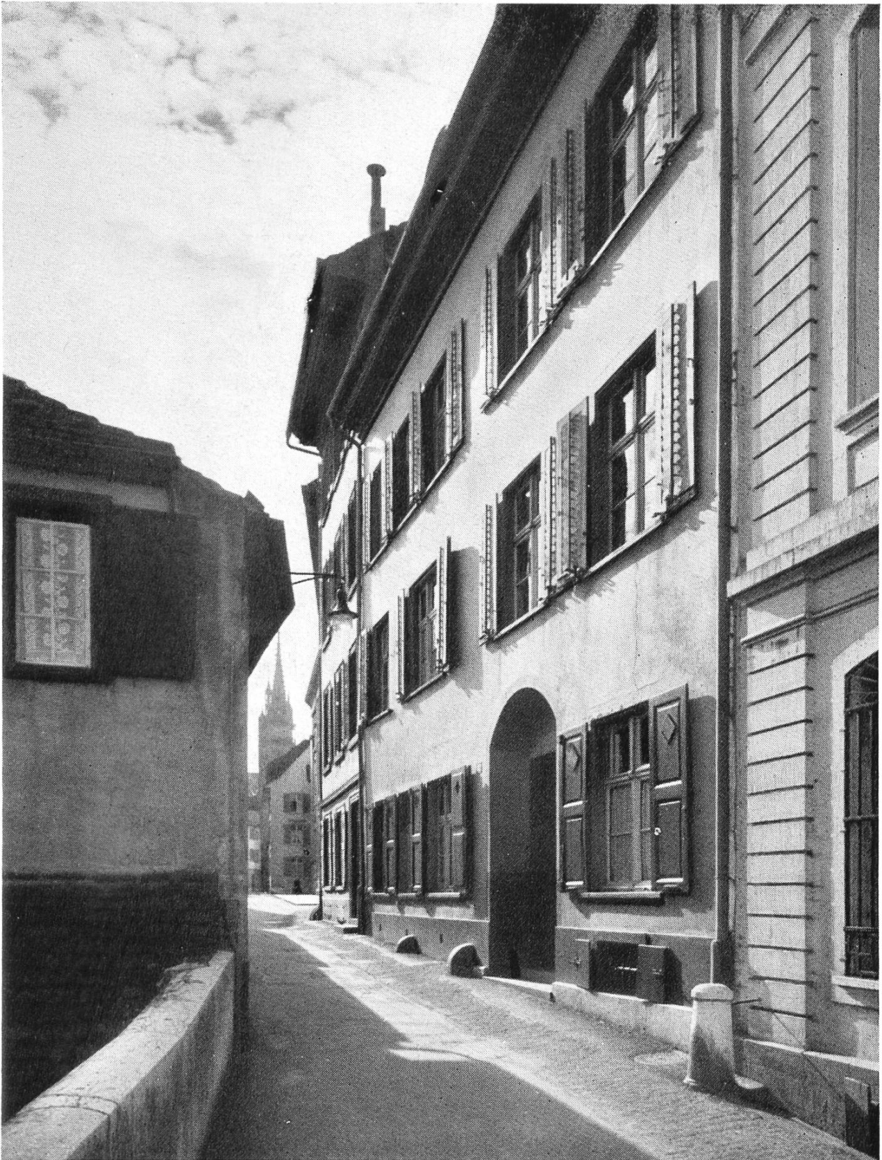
Abb. 1. Das Haus „Zur Augenweide“ am Rheinsprung in Basel.
