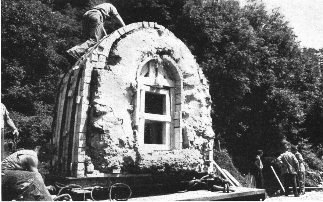
Abb. 54. Ein Stück der römischen Wasserleitung Lausen–Augst wird, wohlverpackt, verladen Photo Lüdin, Liestal
