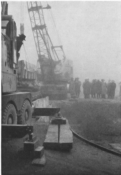
Abb. 55. Die Hebung der Großgrabanlage spielte sich am frühen Morgen des 20. Novembers bei dichtem Nebel mittels zweier Kranwagen von 30 und 37 Tonnen im Beisein einer gerade in Lenzburg tagenden nationalrätlichen Studienkommission ab.
