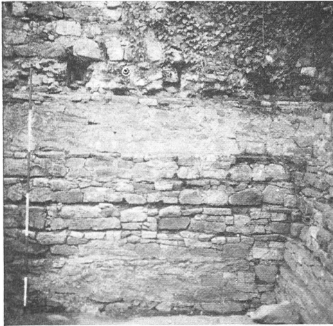
Abb.61. Strahlegg. Westmauer, Nordteil.
