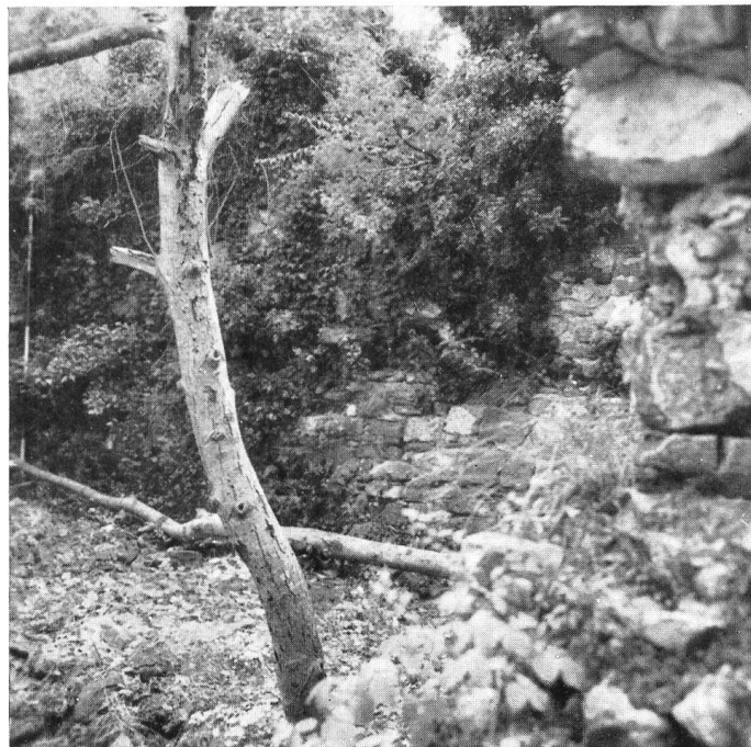
Abb. 55. Strahlegg. Das Innere des Turmes vor Beginn der Ausgrabung.
