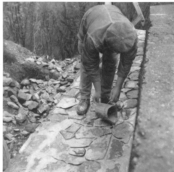
Abb. 49. Ausgießen der Fugen mit Spezialbojacke.
