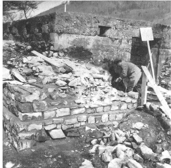
Abb. 47. Beginn der Konservierungsarbeiten: Vormauern.
