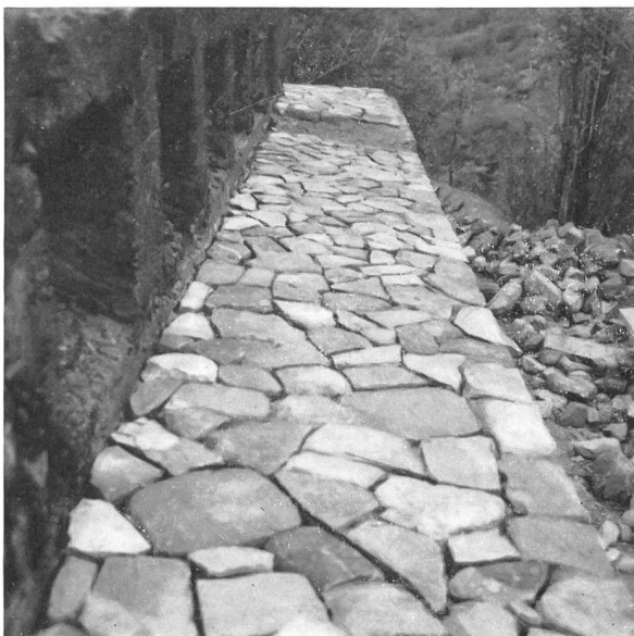
Abb. 48. Abdecken des römischen Mauerwerks mit «Plattenmosaik».
