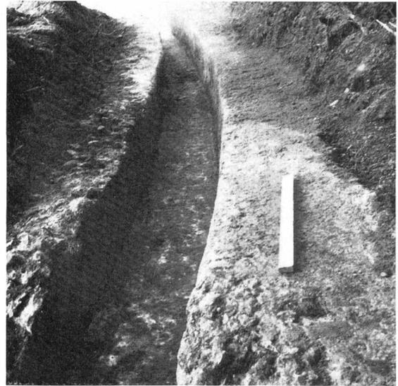
Abb. 38. Kaiseraugst, Hardhof. Römische Wasserleitung, Kanal aus Kalkbeton mit Ziegelbeimischung. Photos H. Bögli.
