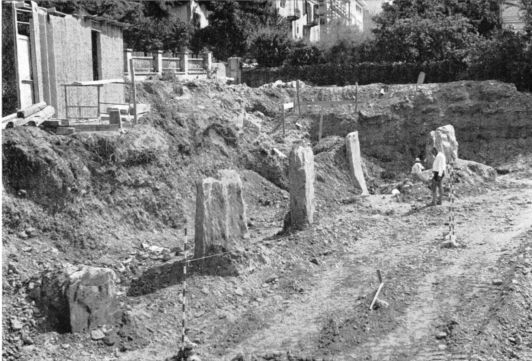
Fig. 65. Sion, Chemin des Collines. Vue générale du Sud-Ouest. Photo Prof. M.-R. Sauter.
