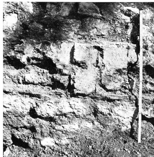
Abb. 30. Schwitzraum, Abdrücke der Heißlufttröhen an der Nordwand. Alle Photos R. Laur-Belart.
