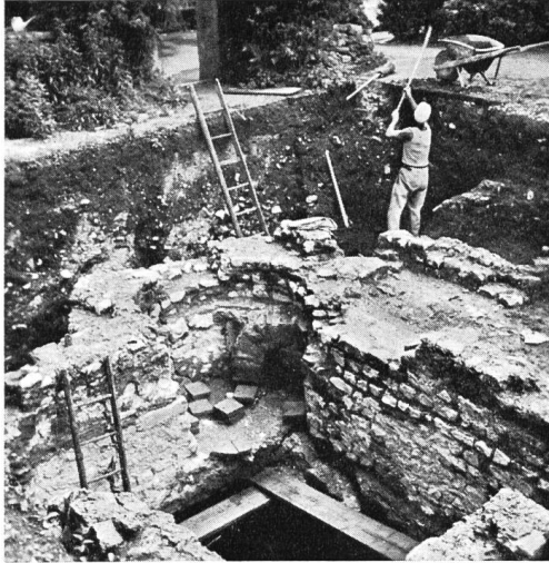
Abb. 27. Schwitzraum von Westen mit Blick auf den Heizkanal unter der Eckkapsis, während der Ausgrabung.
