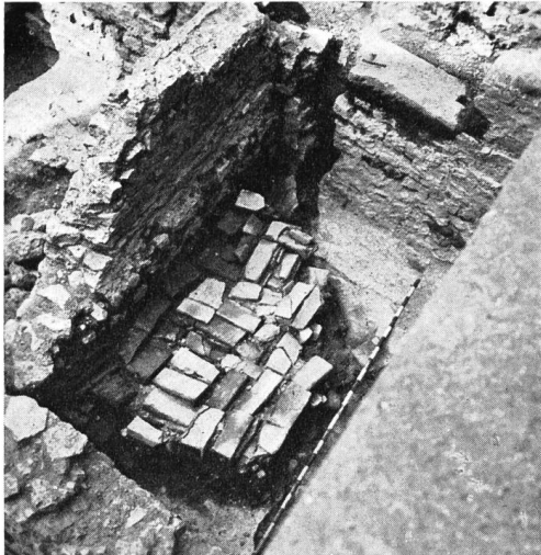
Abb. 31. Kaiseraugst. Bad, Vorwärmeraum mit eingelagerten Heizröhren, oben Türschwelle.
