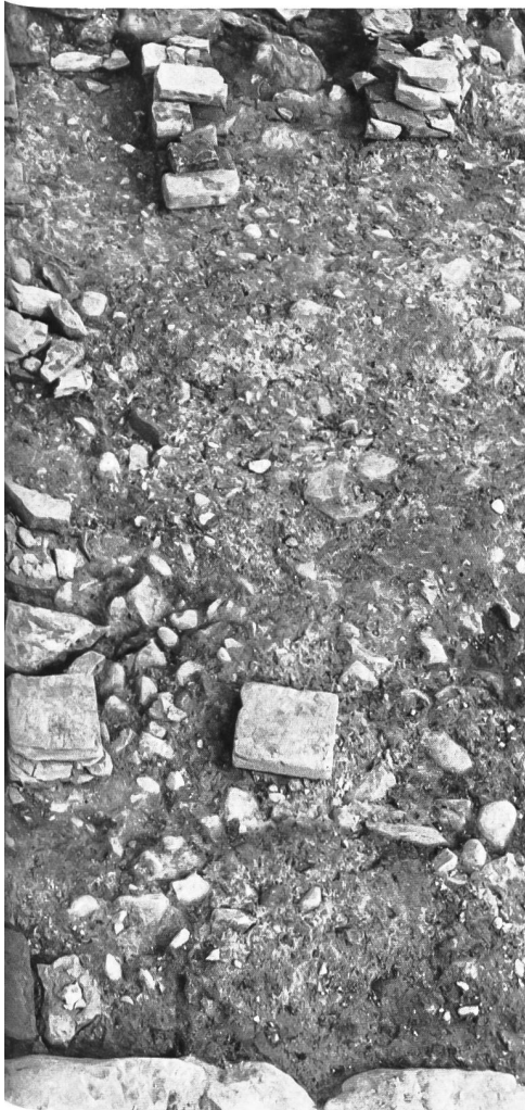
Abb. 23: Raum 2, Hypokaustpfeiler, gegen Norden. Pièce 2, pilier d'hypocauste vers le nord. Camera 2, pilastro dell'ipocausto verso nord.
