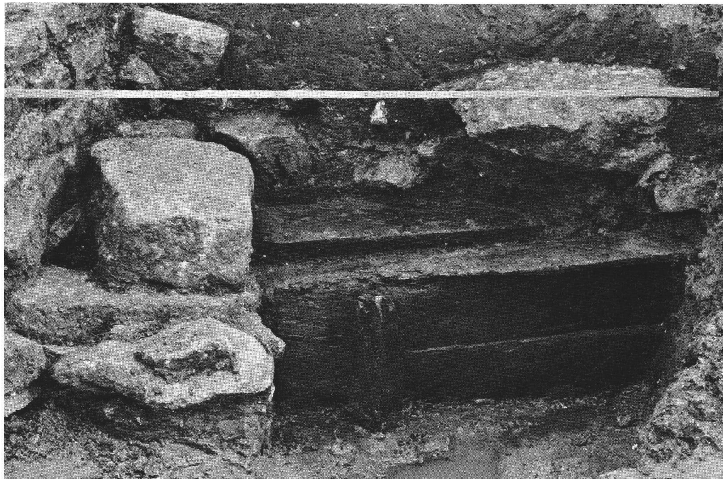
Abb. 7 Übergang vom Holz- zum Steinkanal. Links im Bild die Mauer. Blick von Westen. Le passage du canal en bois au canal en pierre. Conginutura del canale di legno con il canale di sasso.
