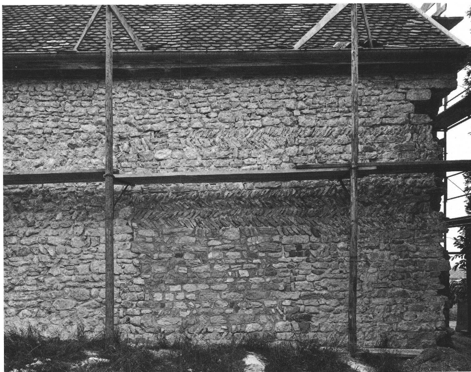
fig. 3 Bonvillars, église. Murs nord. Bonvillars, Nordmauern der Kirche. Bonvillars, mura nord della chiesa.
