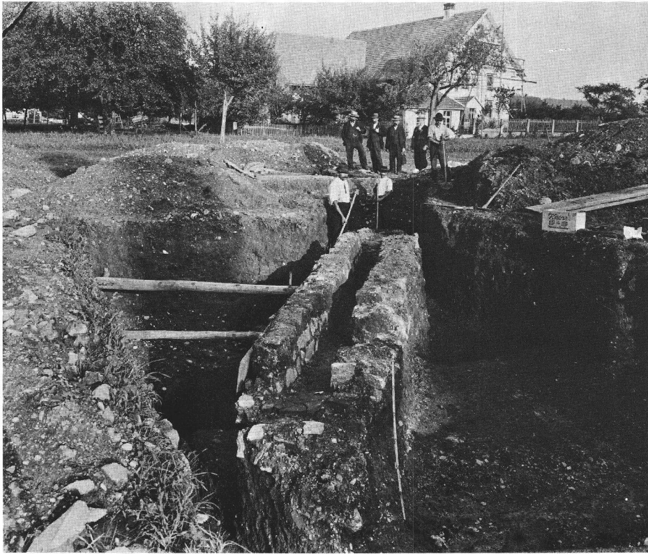
Abb. 1 Ausgrabung von 1914 in der »Breite«. Freilegen eines Abwasserkanals. Fouilles de 1914, »in der Breite«. Dégagement d'une coulèsse. Vindonissa »Breite«. I scavi del 1914.
