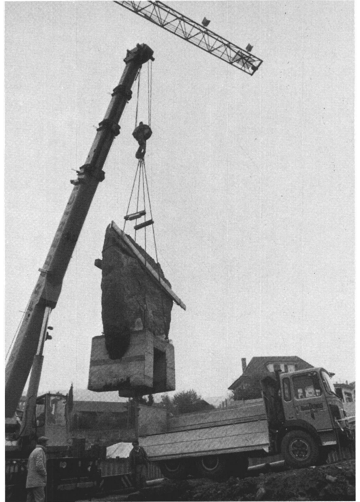
fig. 3 Enlèvement du menhir 6, dont le poids est estimé à 13 tonnes. Photo C. Masserey.
