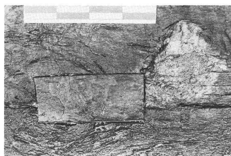
fig. 11b Empièvement rectangulaire sur un noeud du bois. Photo Y. André. Ein durch ein rechteckiges Stück Holz ersetztes Astloch. Un buco d'un nocchio e riempito di un pezzo di legno rettangolare.
