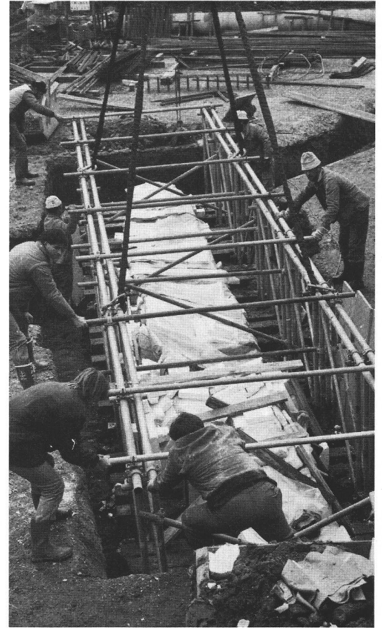
fig. 3c Le fond de canot est emporté en une pièce dans un bâti métallique. Der Schiffsboden wird in einem Stück gehoben. Il fondo del battello è trasportato in un pezzo unico in un cofano metallico.
