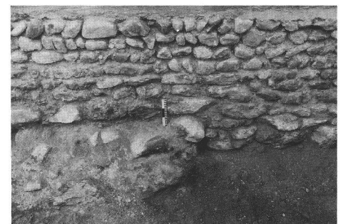
Abb. 4 Nordwestecke des spätrömischen Brückenkopfes unter dem Fundament der Nordmauer der romanischen Kirche. Angle nord-ouest de l'enceinte du Bas-Empire, sous la fondation du mur nord de l'église romane. Angolo nord-ovest del capoponte sotto le fondazioni del muro nord della chiesa romanica.
