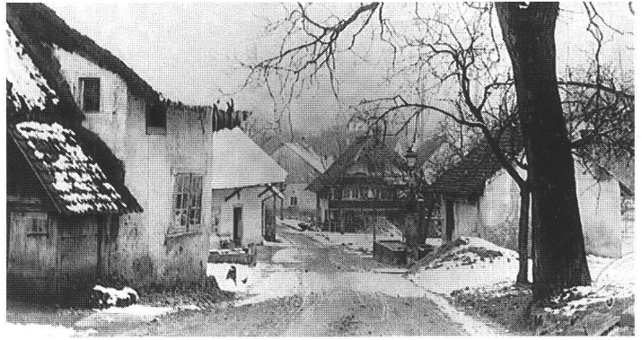
Abb. 16 Der ehemalige »Brunnenrain« 1898 (heute »Lindhofstrasse«) in Oberburg, Windisch. Rechts der »Bärenbrunnen« sowie das Gemeindegewaschhaus und Feuer- wehrmagazin. L'ancien »Brunnenrain« (actuel »Lindhofstrasse«) à Oberburg, Windisch. A droite, le »Bären- brunnen« ainsi que le lavoir communal et le local du feu. L'antico »Brunnenrain« (oggi »Lindhofstrasse«) a Oberburg presso Windisch. A destra il »Bärenbrunnen« come pure il lavatoio comunale e il deposito dei pompieri.
