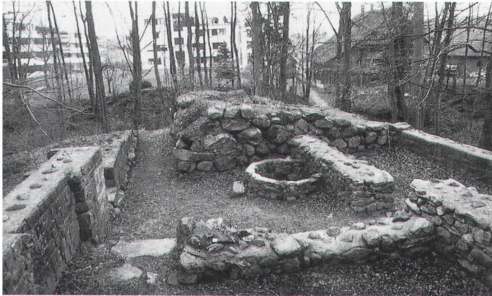
Abb. 9 Hünenberg, Burgruine. Zustand 1994, Blick Richtung Südost; rechts im Hintergrund ist die Rückfront des Burghuuses zu erkennen. Foto H. Remy. Hünenberg, Burgruine. Etat en 1994, vue vers le sud. Hünenberg, Burghuus. Situazione 1994, veduta verso sud; a destra si riconosce sullo sfondo la facciata nord del Burghuus, ora arretrata.
