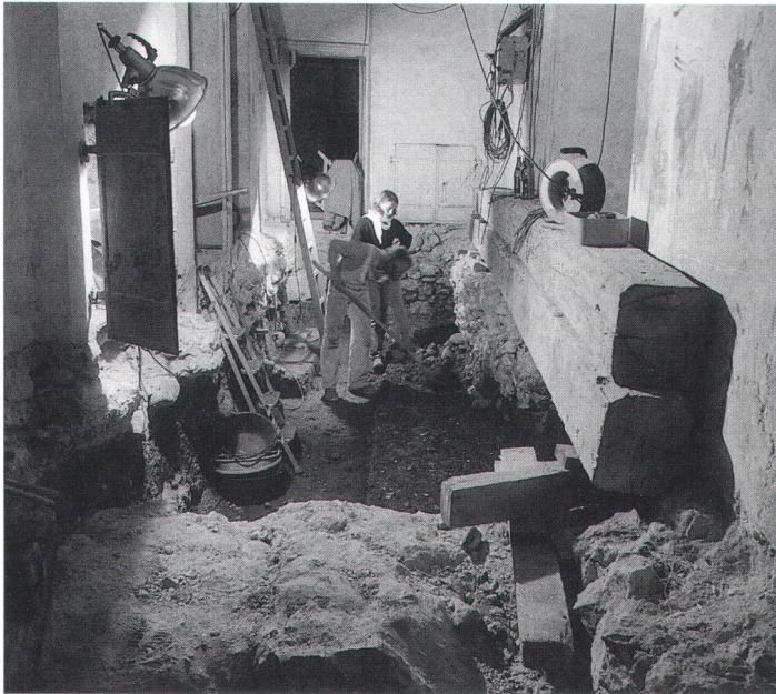
Abb. 3 Freilegen der Schichten im Korridor des Alten Spitals. Dégagement des niveaux dans le corridor de l'ancien hôpital. Messa in luce degli strati nel corridoio dell'Ospedale Vecchio.
