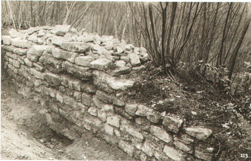
Fig. 113 Tronçon de la fortification du Bas-Empire au Bois de Châtel, dégagé par Albert Naef en 1910.
