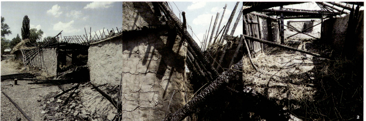
Abb. 2 Seitlich abgerutschte Dachkonstruktion, nach aussen gekippte Lehmwände, Brandschuttkonzentration in den Gassen. Fotos: Amt für Städtebau der Stadt Zürich, Unterwasserarchäologie.
