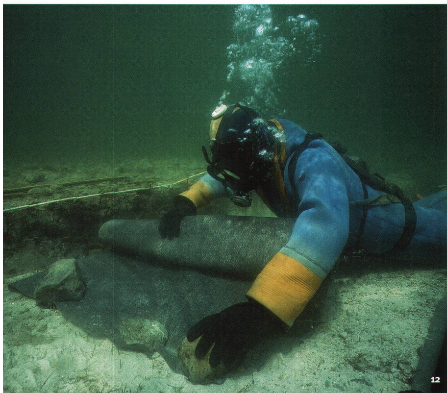
Fig. 12 Mise en place de géotextiles par un plongeur. Le gravier déversé au-dessus protège les niveaux archéologiques d'une destruction irrémédiable.
