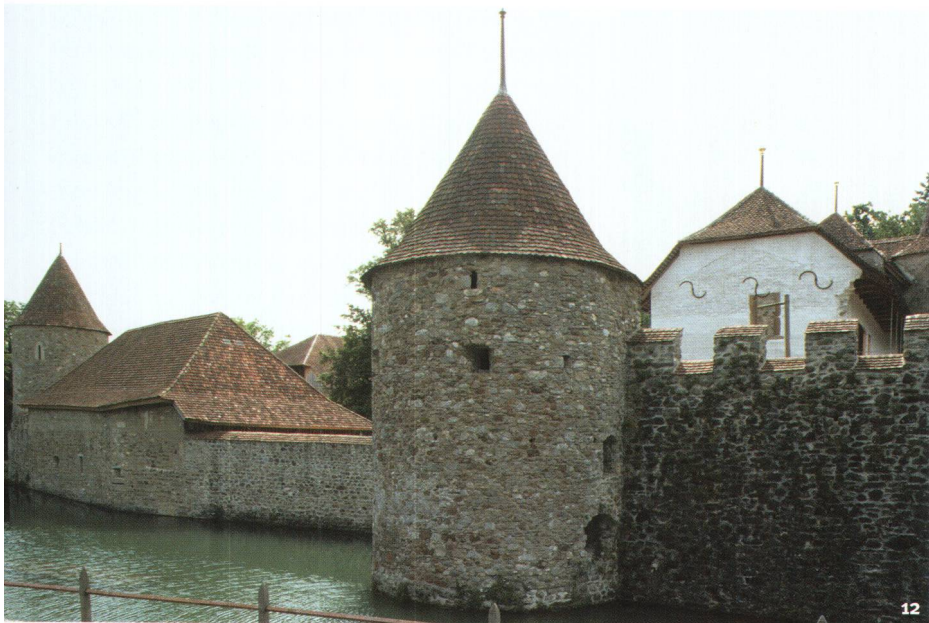
Fig. 12 Le château de Hallwyl. Tour d'artillerie septentrionale rattachée au château central et édiflée vers 1500.
