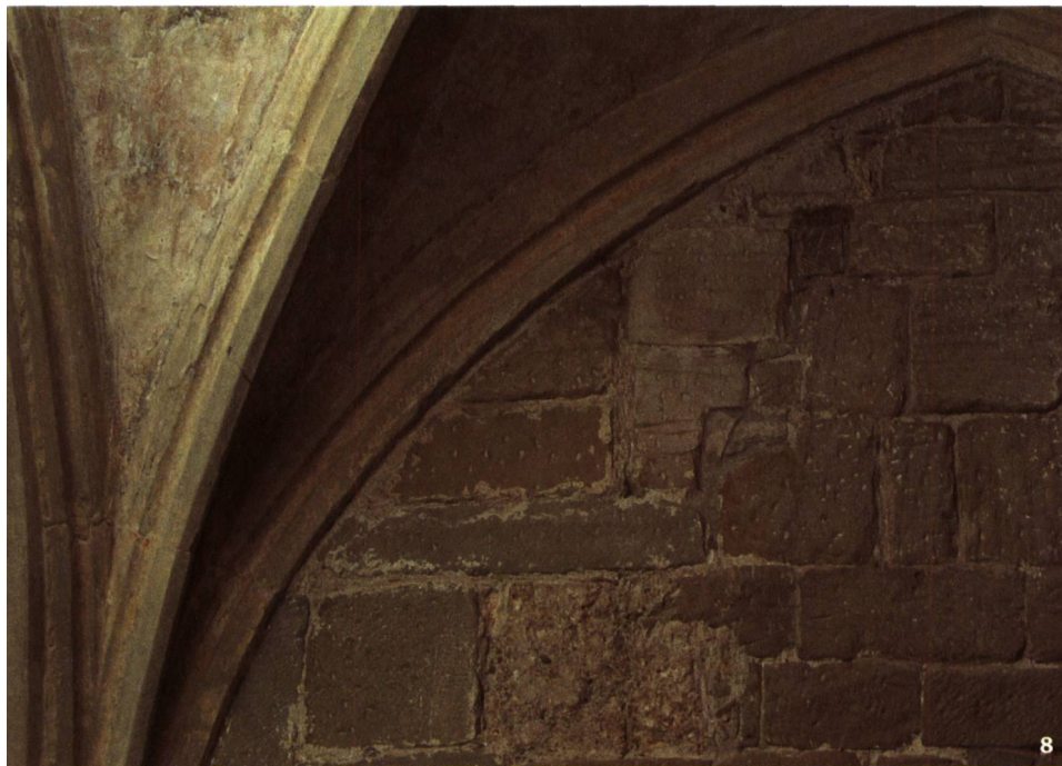
Fig. 8 Vestiges d'une porte donnant accès au dortoir des convers. Percée au 13 e siècle probablement dans les élévations romanes, elle a été condamnée par l'installation des voûtes dans le cloître lors du chantier gothique du 14 e siècle.
