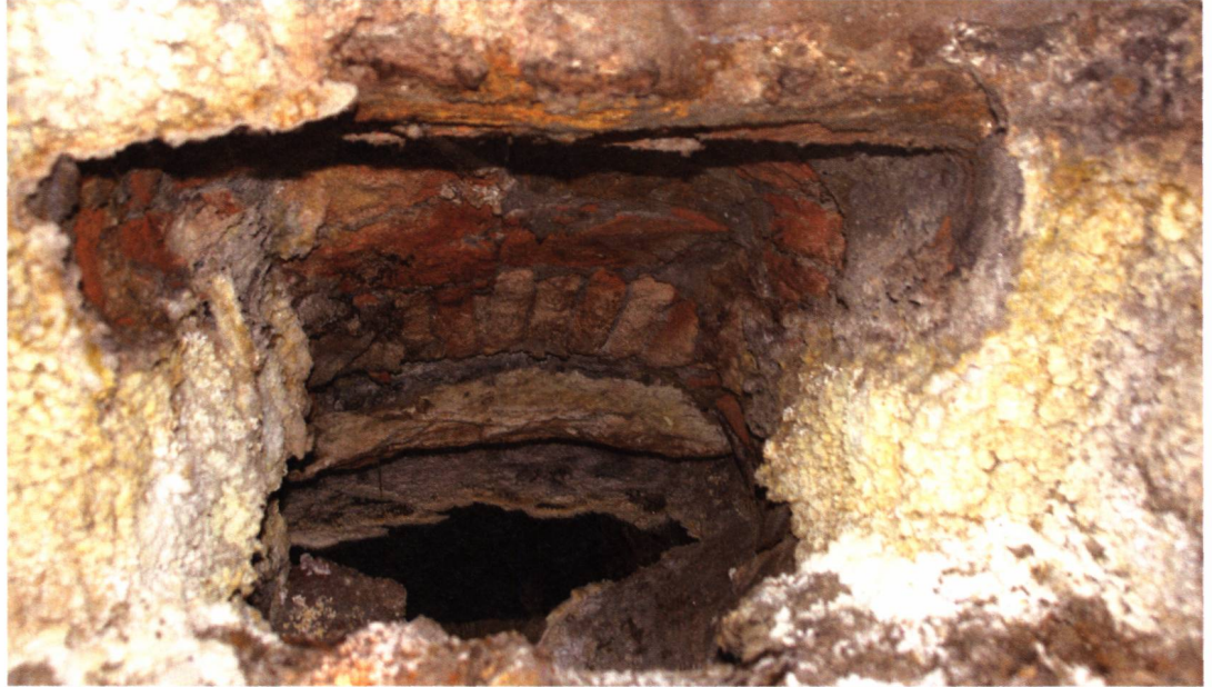
Abb. 4 Baden (AG). Hotel Bären, Hinterhofquelle. Die Quellfassung soll angeblich römisch sein. Photo Kantonsarchäologie Aargau.
