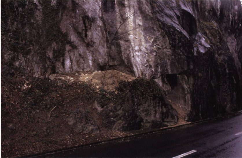
Zustand der Fundstelle Rüthi-Hirschsprung (SG) nach der Raubgrabung.
