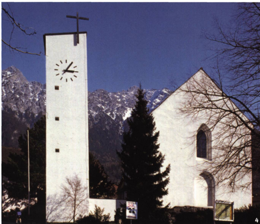
Abb. 4 Schaan-St. Peter (FL). Ansicht von Westen.
