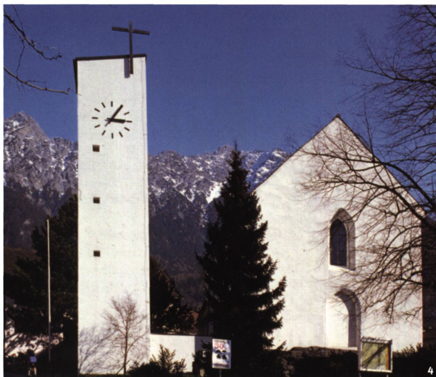
Abb. 4 Schaan-St. Peter (FL). Ansicht von Westen.
