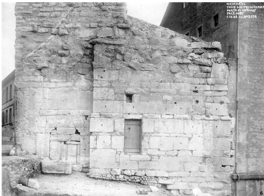
Fig. 6 La partie inférieure de la tour des Prisons en 1922.
