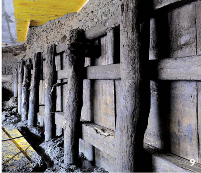
Abb. 9 Uferverbauung des Zürcher Seehafens von 1862.
