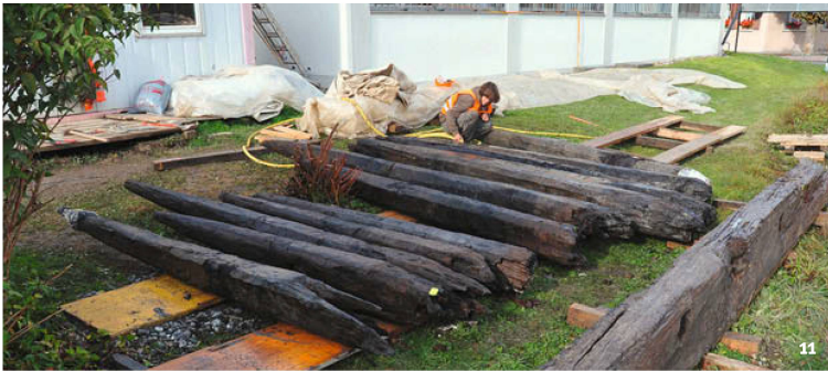
Abb. 11 Die Pfähle der Brücken- und Dammkonstruktion wurden vor Ort gewaschen und dokumentiert.
