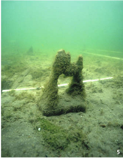
Fig. 5 Un pieu de pont préhistorique près de Hurden. L'orifice servait à faire passer une poutre transversale pour éviter que le pieu ne s'enfonce.
