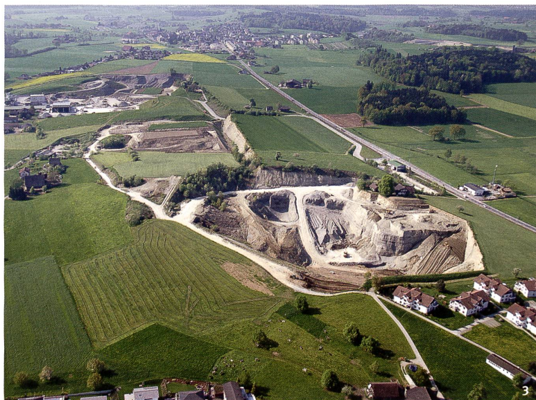
Abb. 3 Kiesgruben im Seetal. Im Vordergrund die Gemeindegroben Ballwil, dahinter die Kiesgrube Löttscher. Hinten rechts ist das Kieswerk Eschenbach erkennbar.
