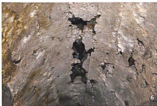
porte encore, dans le mortier de chaux recouvrant la surface interne de la voûte, les empreintes du cintre en bois utilisé lors de la construction.
