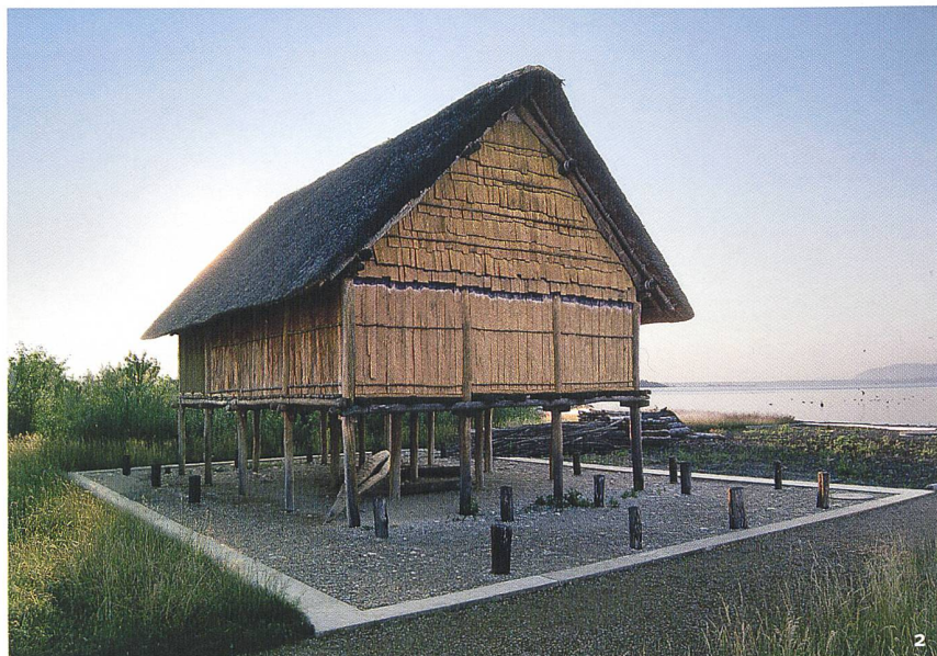
Fig. 2 Maison à trois nefs (quatre rangées de pieux) du Bronze final reconstituée dans le parc du Laténium.
