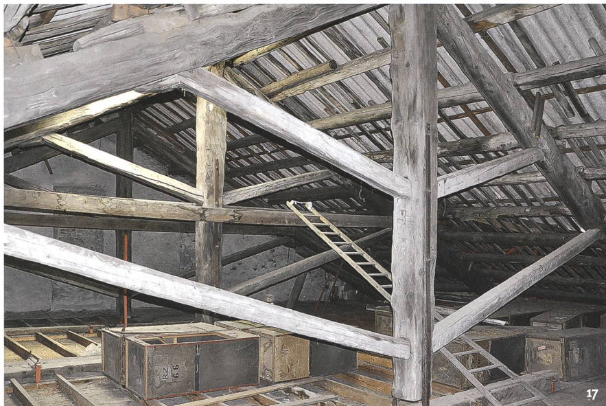
Fig. 17 Carpenteria originale della vetreria settecentesca di Lodrino. Originaler Dachstuhl der Glashütte von Lodrino aus dem 18. Jh. Charpente d'origine de la verrerie du 18 e siècle de Lodrino.
