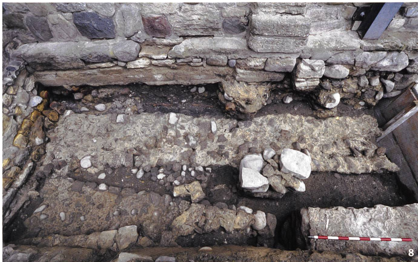
Fig. 8 Vue du mur de l'extension nord et de la fondation pour un renfort (en rosé sur le plan), au pied de la façade nord de l'église romane.
