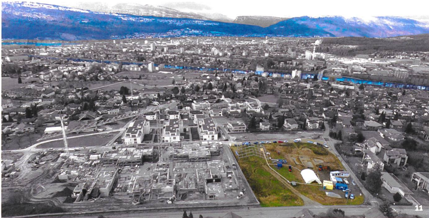
Abb. 11 Port-Bellevue. Im Vordergrund die Rettungsgrabung, im Hintergrund zeigt der Panoramablick nach Norden. Blau eingefärbt sind Jura und Bielersee sowie der heutige Nidau-Büren-Kanal.
