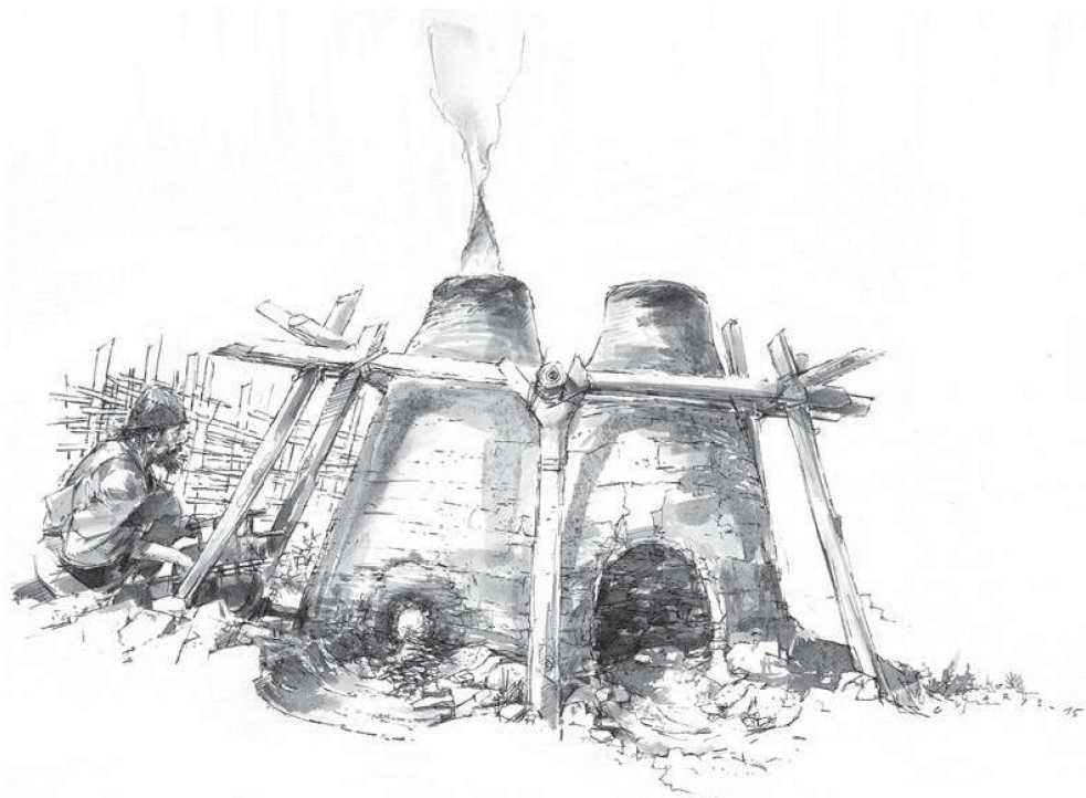
Fig. 6 Restitution de deux bas-fourneaux dans lesquels on réduisait le minerai de fer.
