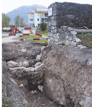
1 Blick auf den freigelegten (l.) sowie einen rekonstruierten (r.) Abschnitt der Letzimauer. © Larissa König, ProSpect.
