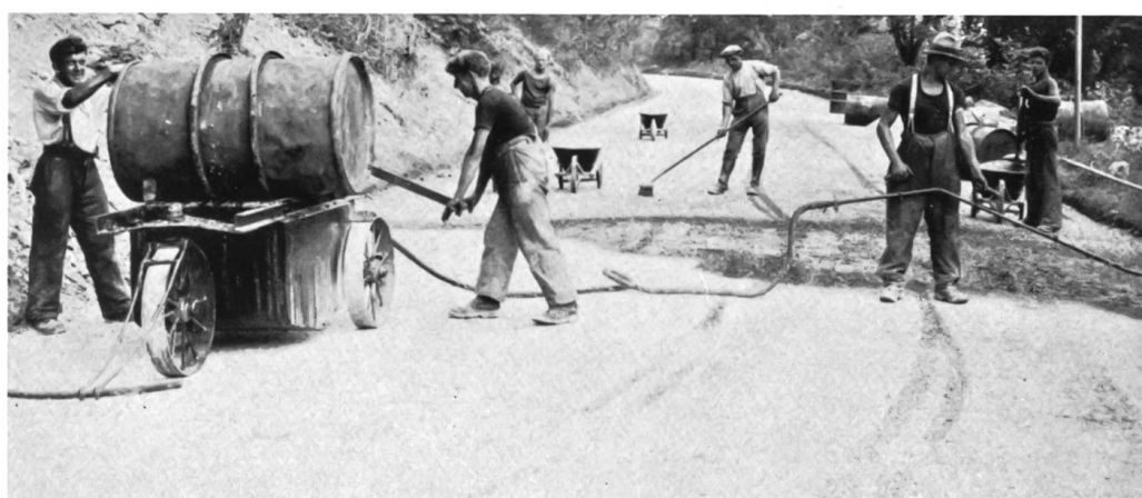
Bitumulstränkung auf der Hauensteinstrasse.
