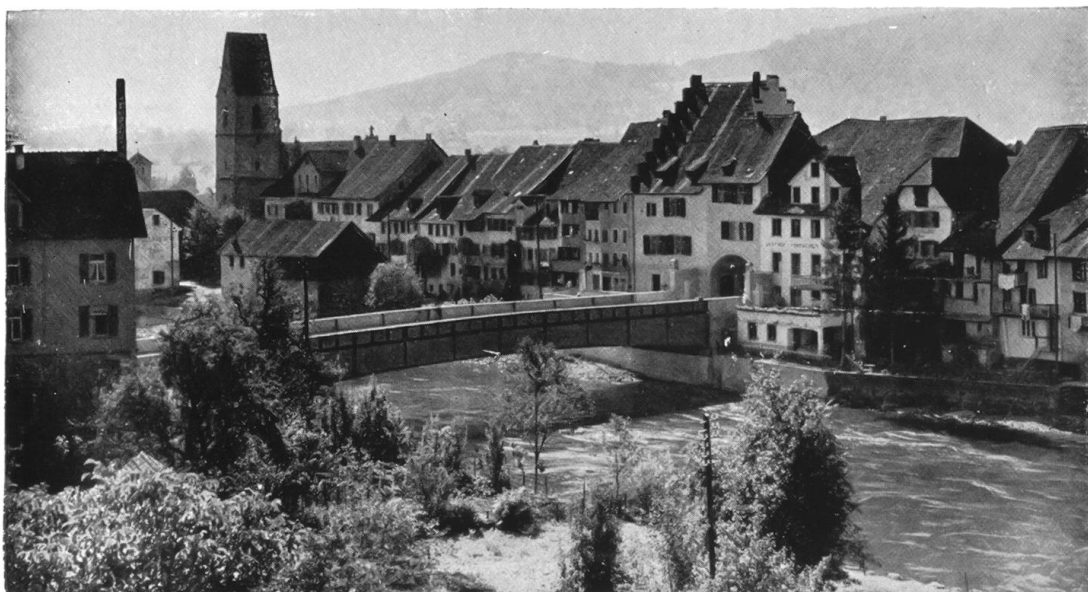
Eiserne Strassenbrücke über die Reuss bei Mellingen
