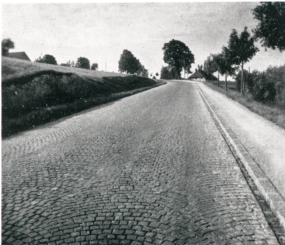
Steile Partie auf der Nordrampe der „Vue des Alpes“, ausgeführt von der Stuaag mit schweizerischen Kalksandsteinen.
